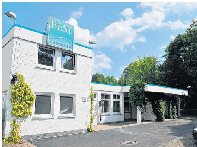
Die Autowaschstraße Best Carwash an der Stahlwerkstraße in Geisweid. Rechts schließt das Gebäude mit zwei Hallen für die Innenreinigung der Fahrzeuge ab. Fotos: rai
